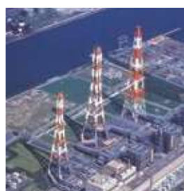
電力会社発電所
